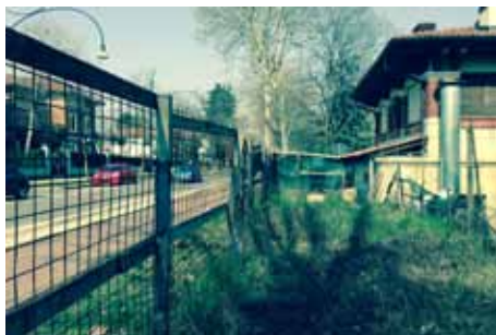
La Torre dell'acquedotto: più che da una recinzione è chiusa in una stia di polli.
