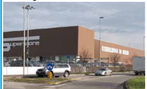
LA REALTA' - Realizzazione di Desio, indicatoci come esempio da Esselunga, fotografato sempre da 80 metri
